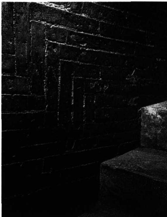
5. Florenz, Domkuppel. Fischgrätverband an der inneren Kuppelschale seitlich eines Treppenaufgangs
